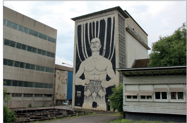
Fassade im Kulturraum Attisholz in Solothurn
